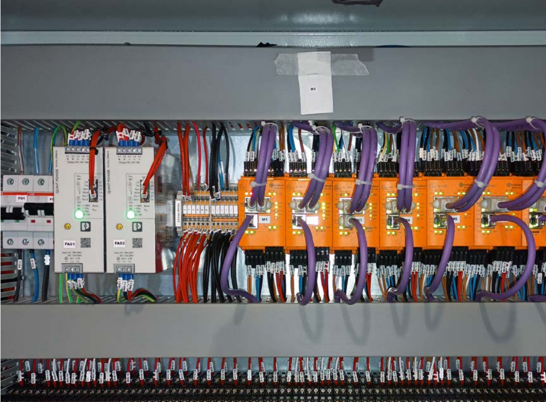
振動感測器的 IO-Link 主站和評估單元收集資料，並以整合的形式傳輸到 IT 層級。
