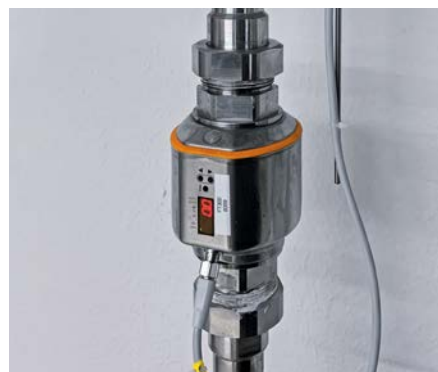
Le capteur de débit transmet simultanément plusieurs valeurs de mesure au système de commande via IO-Link.
