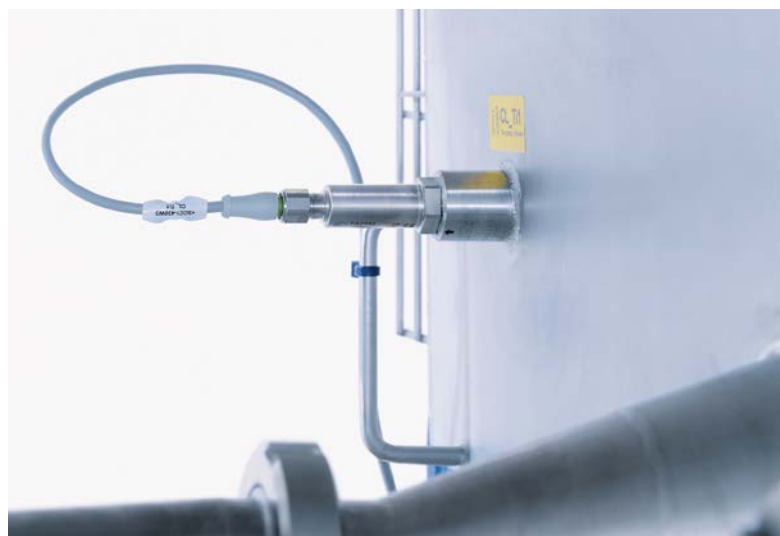
I sensori di temperatura TA monitorano i valori di temperatura da rispettare con precisione sia nel bagno di cottura che nel bagno di raffreddamento.
