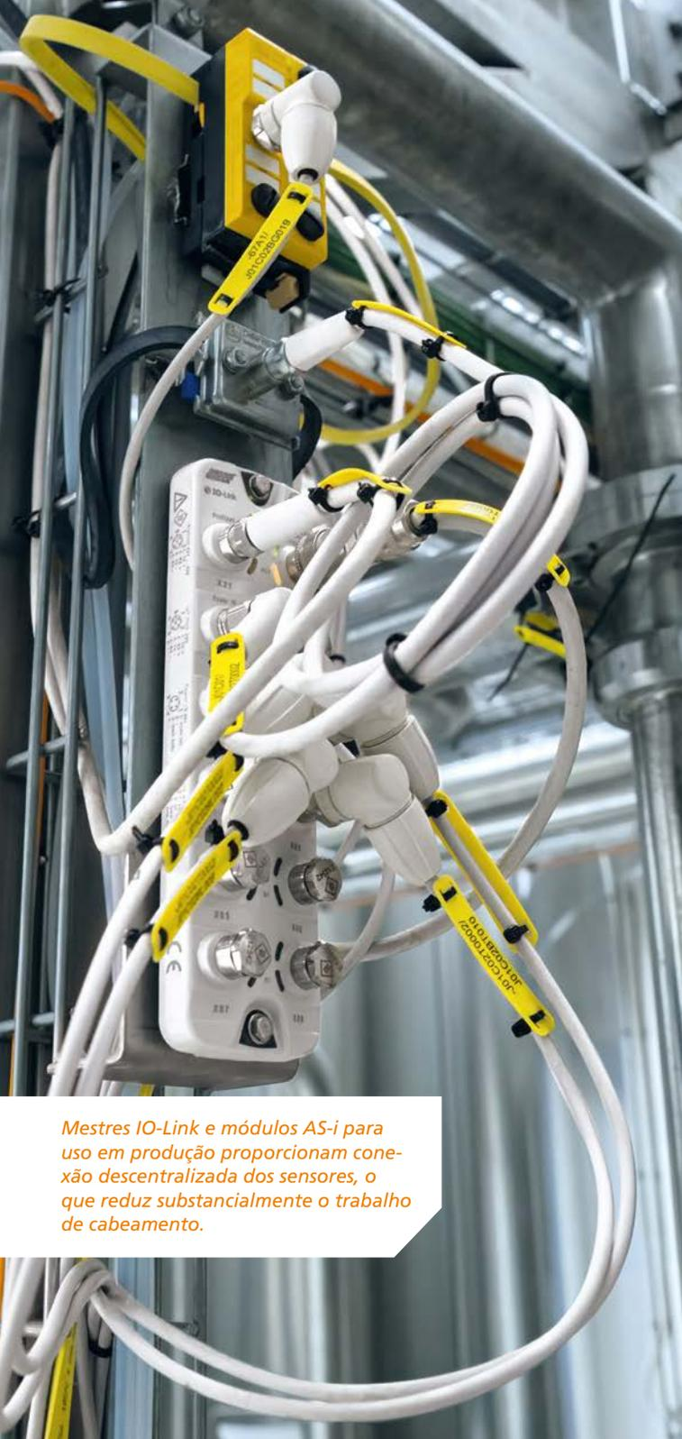
Mestres IO-Link e módulos AS-i para uso em produção proporcionam conexão descentralizada dos sensores, o que reduz substancialmente o trabalho de cabeamento.
