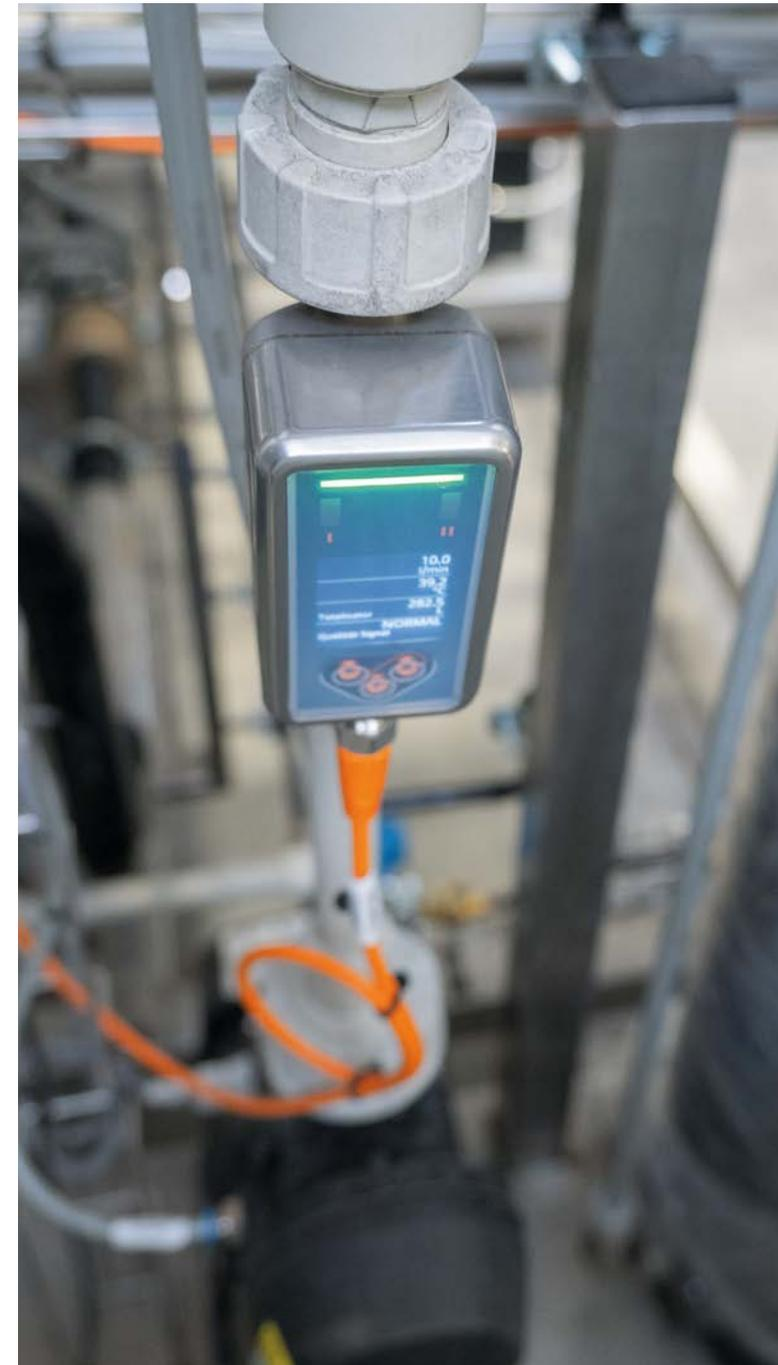
*Todos os sensores estão conectados via IO-Link. Isso acelera a entrada em operação, simplifica a parametrização e permite o diagnóstico remoto até o nível do sensor.*
