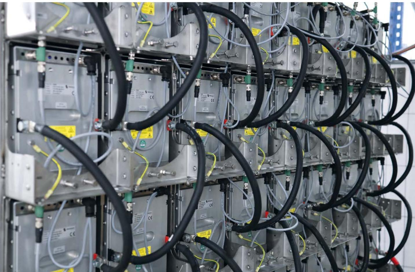
*As 32 células de combustível PEM de baixa temperatura produzem a energia para impulsionar o navio.*
