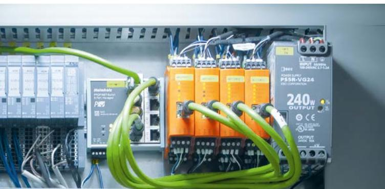
*A eletrônica de avaliação no painel elétrico processa os dados dos sensores de vibração e envia os resultados via Ethernet para o gateway, o controlador IIoT da ifm.*
