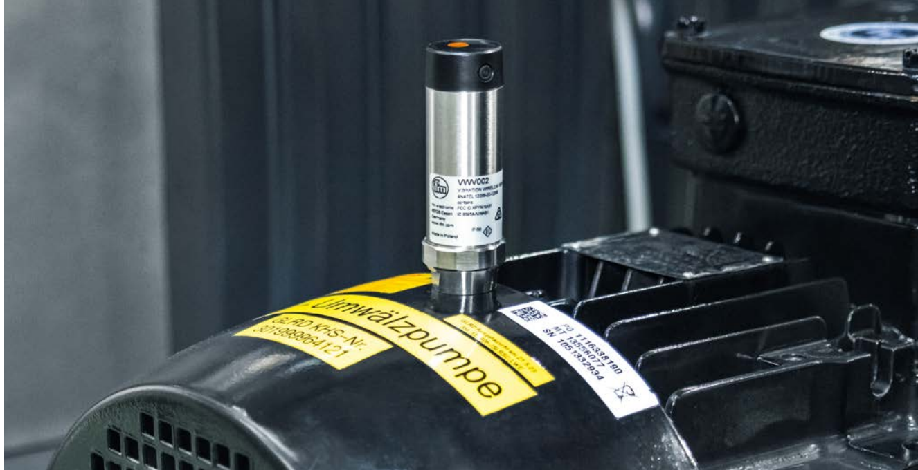
Un sensor de vibración inalámbrico en la bomba de circulación para una supervisión fiable e intermitente de la vibración total según la norma DIN ISO 10816.
