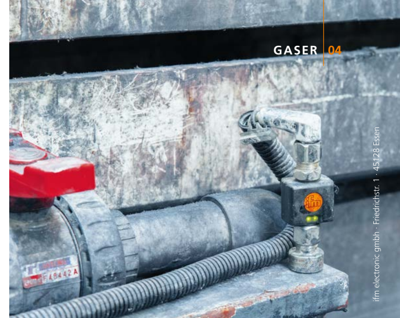
Temperaturstabsensor, Auswerteeinheit und Kabel widerstehen den harten Umgebungsbedingungen des Eloxierprozesses.
