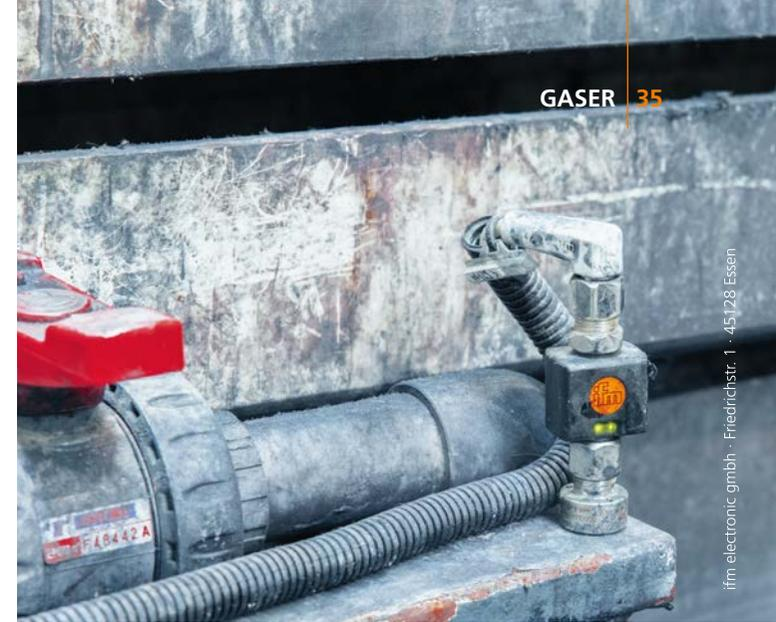
El sensor de temperatura, la unidad de evaluación y los cables resisten las duras condiciones ambientales del proceso de anodizado.
