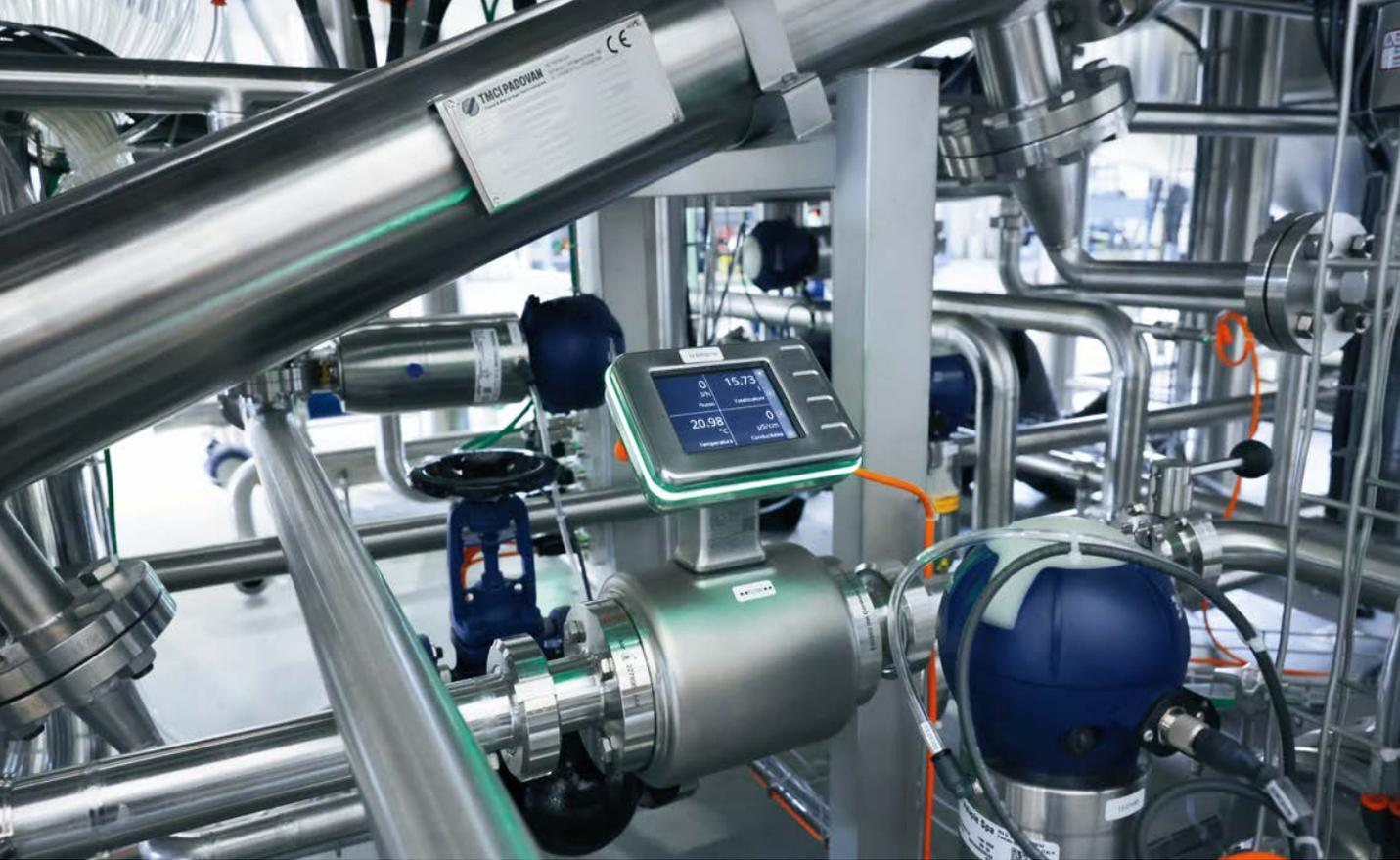
*El SM Foodmag registra tres importantes magnitudes de medición —caudal, conductividad y temperatura— en un solo punto de medición.*
