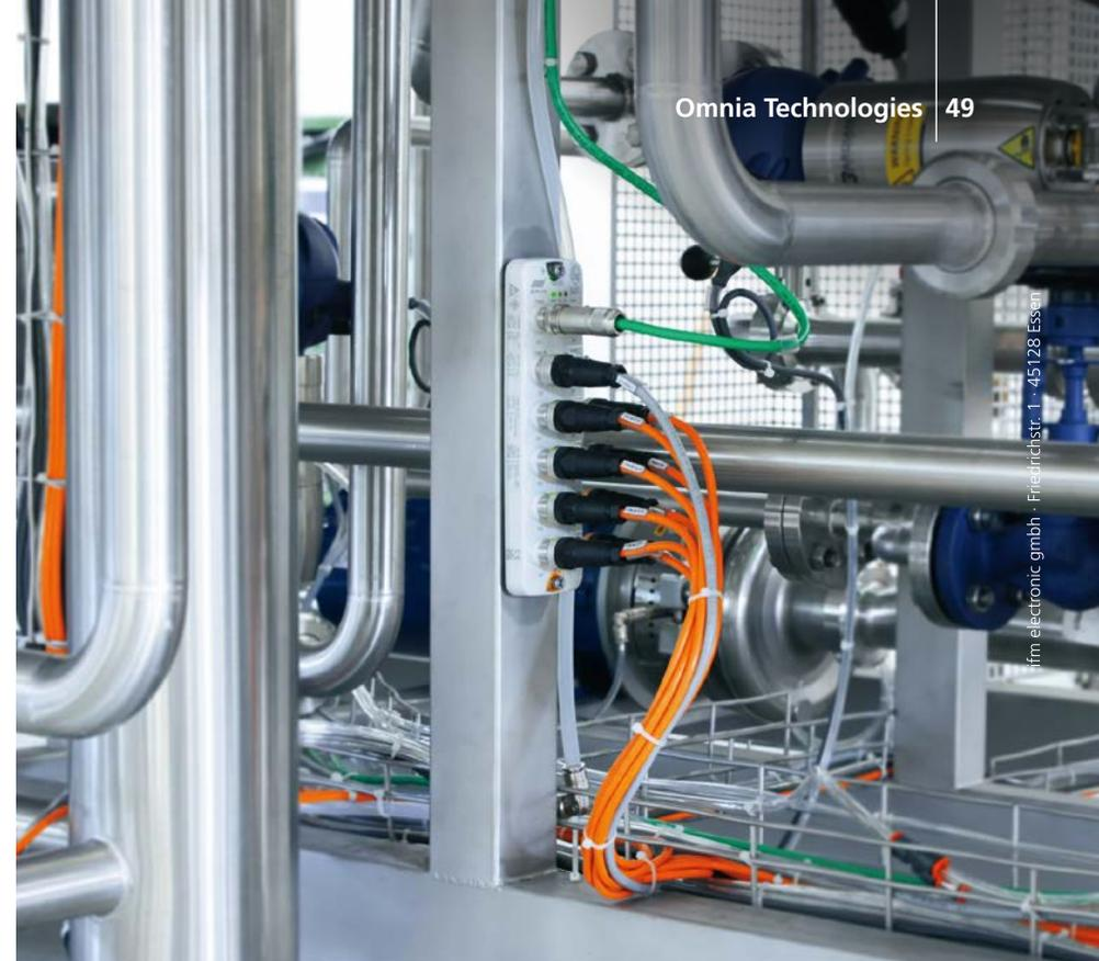
*El maestro IO-Link para aplicaciones de campo recopila los datos de los sensores de forma descentralizada y los transmite en paquetes al controlador.*
