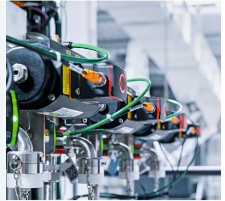
Sistemas de señalización para válvulas
