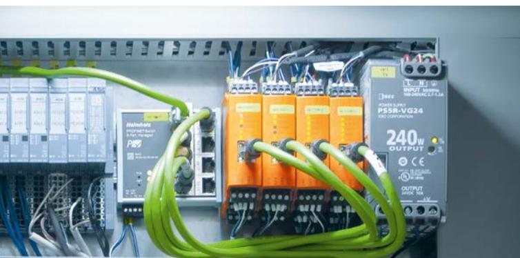
*La centralina di controllo situata nel quadro elettrico elabora i dati dei sensori di vibrazione e trasmette i risultati al gateway, il controller IIoT di ifm, tramite Ethernet.*
