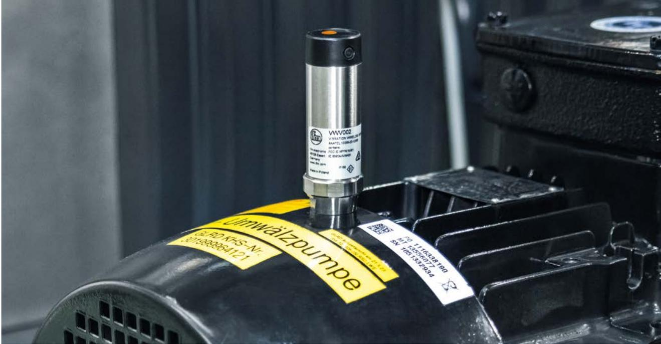
Un capteur de vibrations sans fil, installé sur la pompe de recirculation, permet une surveillance fiable et intermittente des vibrations globales conformément à DIN ISO 10816.
