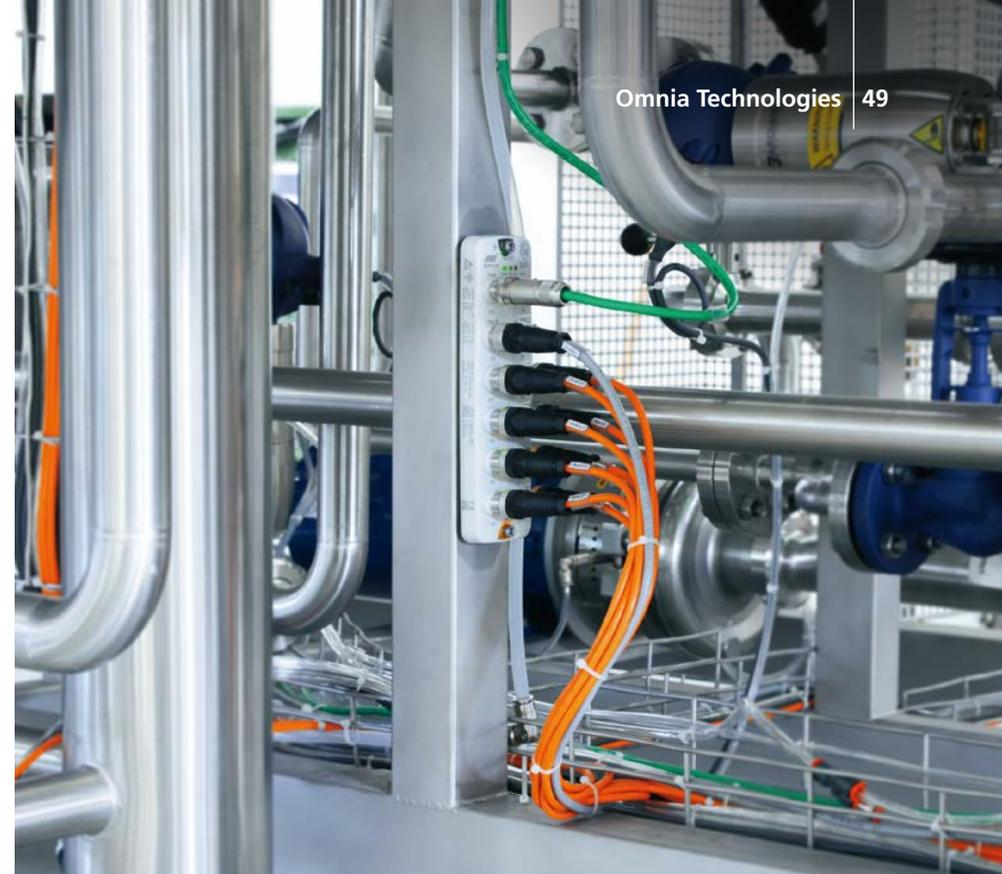
*Le maître IO-Link adapté au terrain collecte les données des capteurs de manière décentralisée et les transmet de façon centralisée à la commande.*
