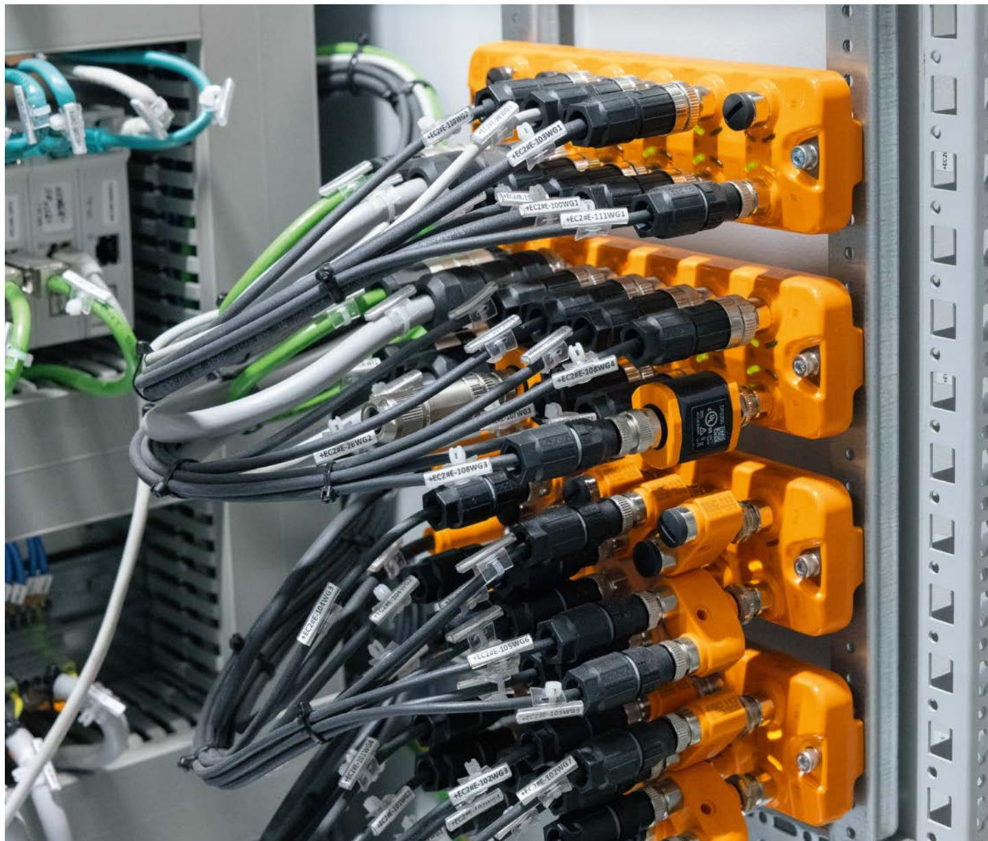
*Les fonctions orientées sécurité peuvent également être réalisées via des maîtres IO-Link spéciaux.*
