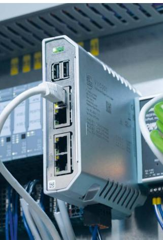
Los datos de los sensores de la instalación de reciclaje se recopilan de forma descentralizada a través del maestro IO-Link y se envían agrupados al sistema de control.
