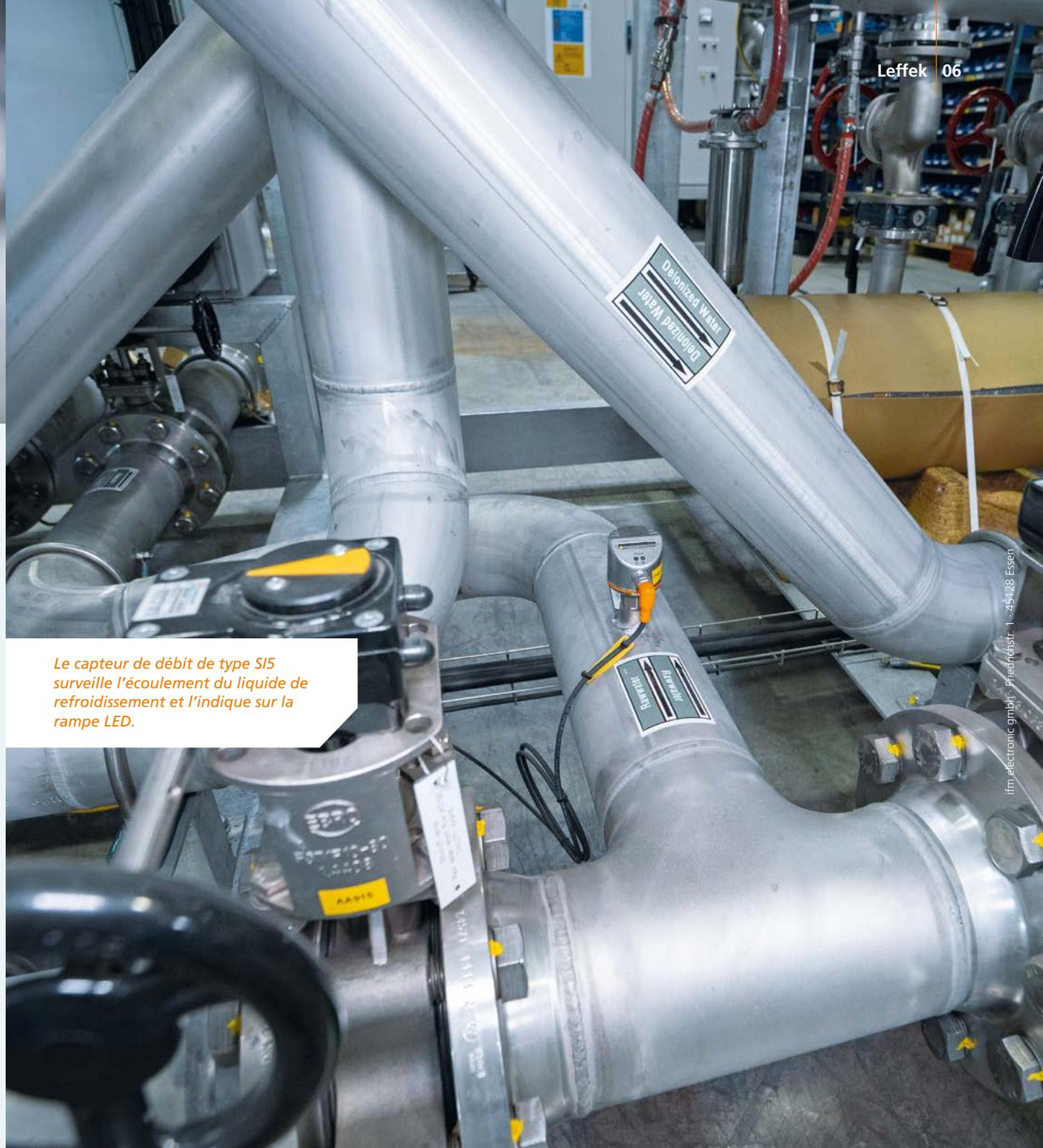
*Le capteur de débit de type S15 surveille l'écoulement du liquide de refroidissement et l'indique sur la rampe LED.*
