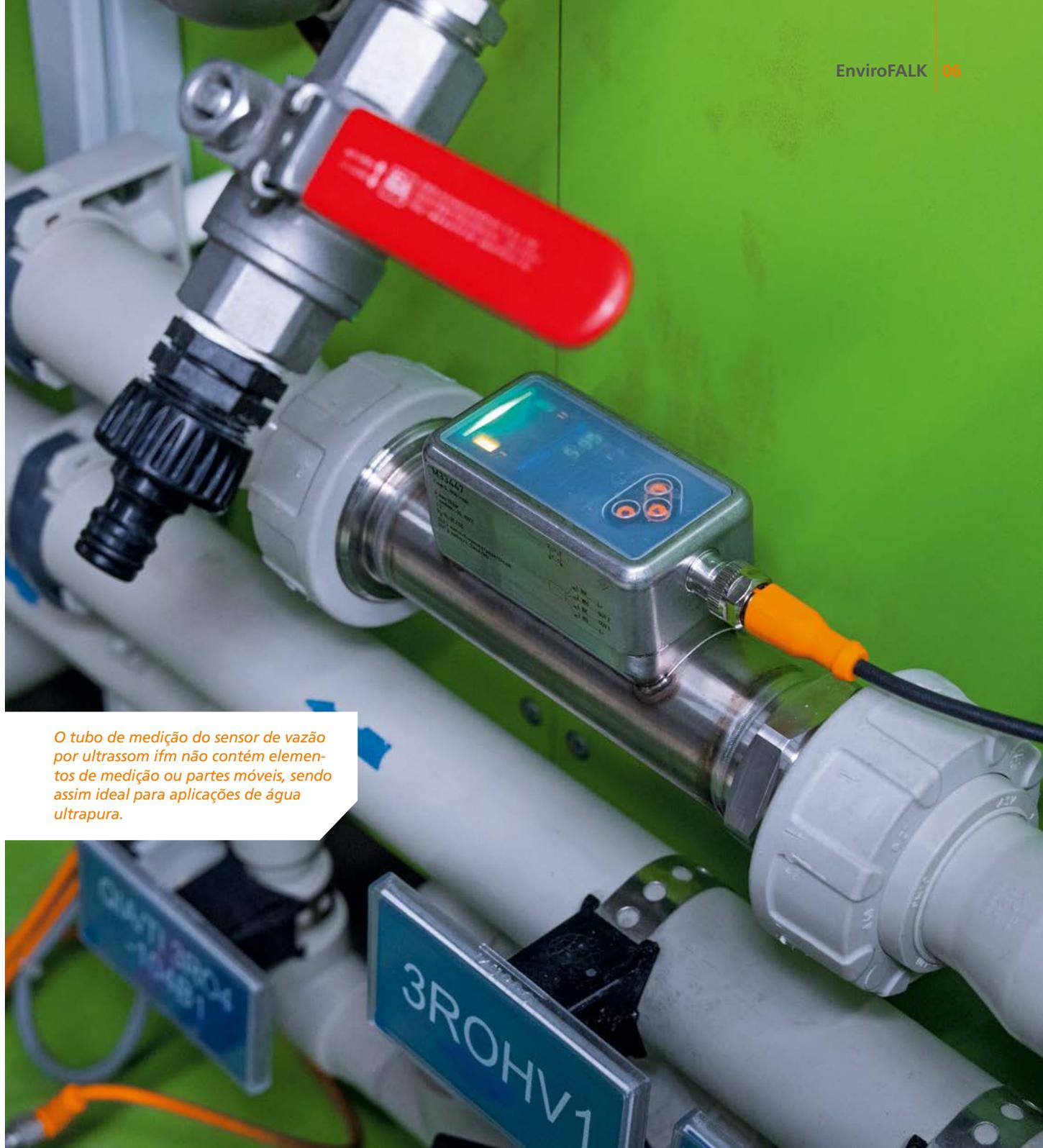
*O tubo de medição do sensor de vazão por ultrassom ifm não contém elementos de medição ou partes móveis, sendo assim ideal para aplicações de água ultrapura.*
