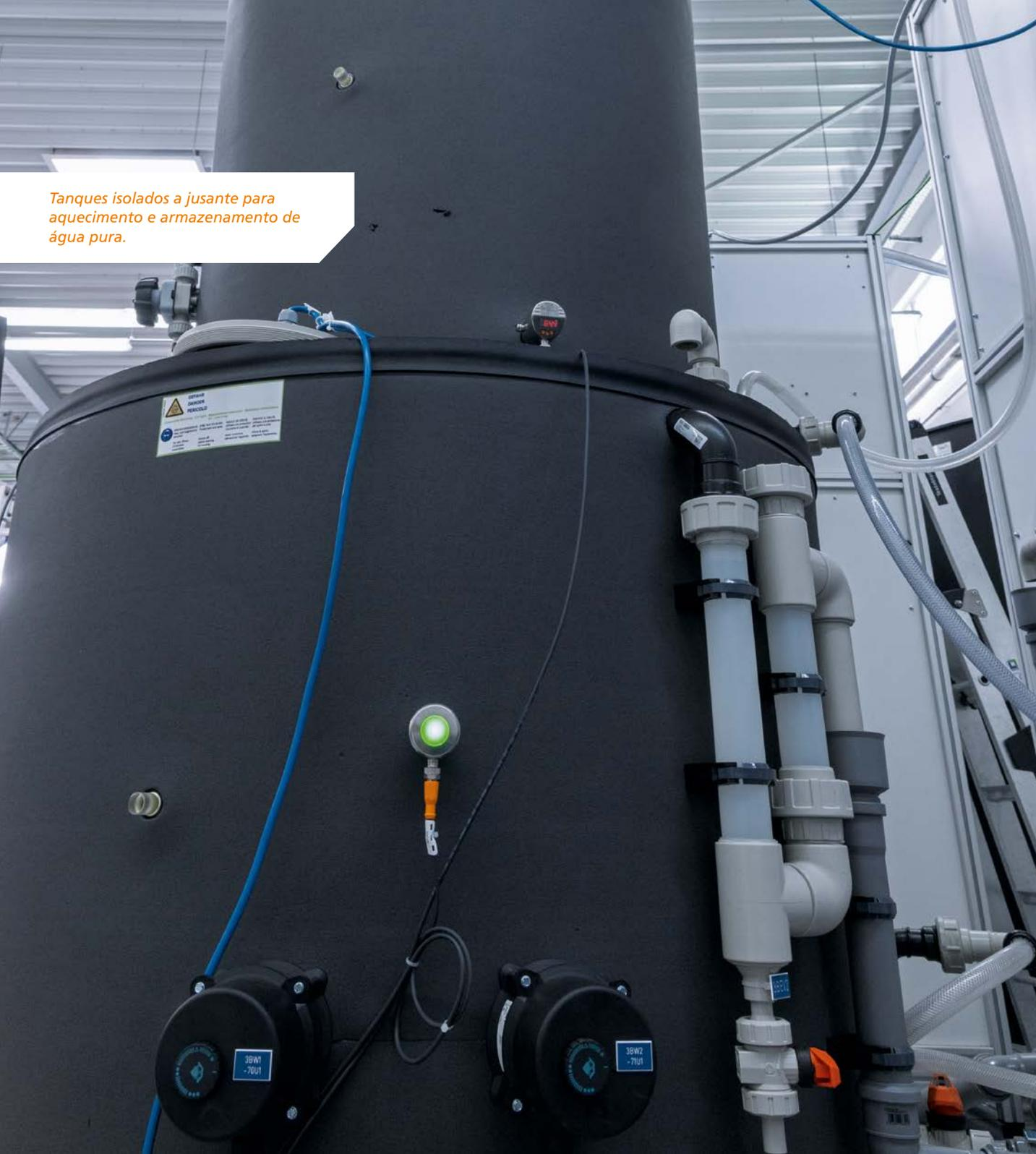
Tanques isolados a jusante para aquecimento e armazenamento de água pura.
