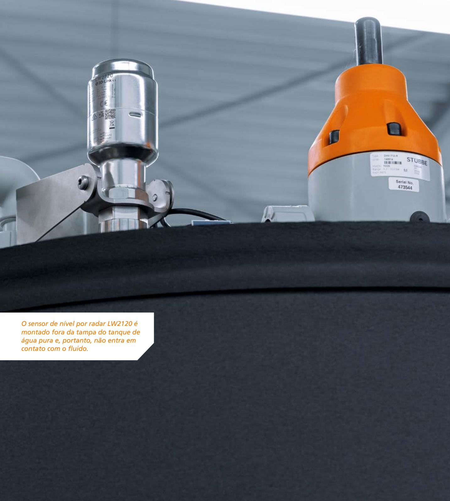
O sensor de nível por radar LW2120 é montado fora da tampa do tanque de água pura e, portanto, não entra em contato com o fluido.
