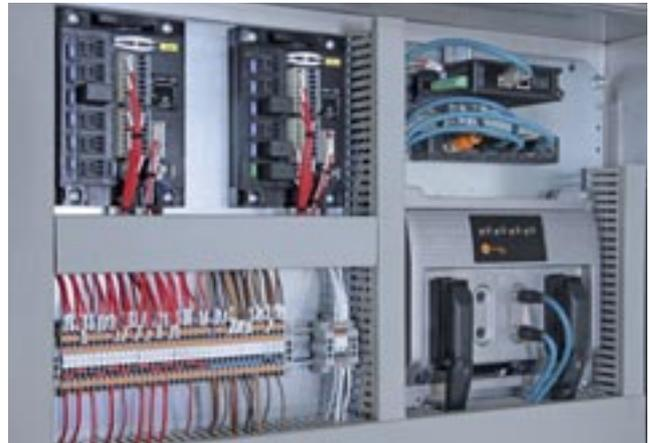
Die zentrale mobiltaugliche Steuerung ecomatController von ifm (rechts unten montiert) ist im Schaltschrank im Außenbereich des Fahrzeugs montiert.
