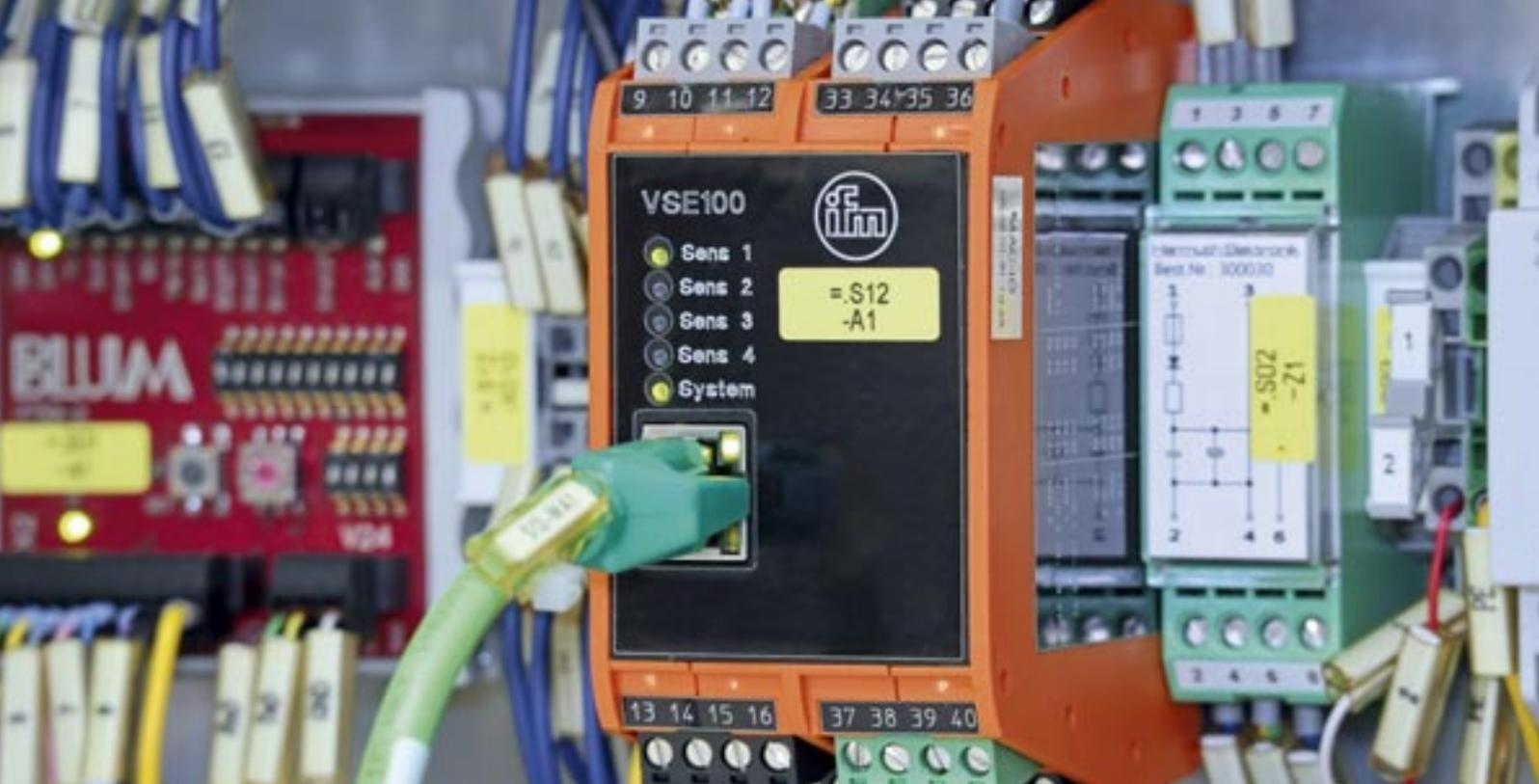
Verarbeitet die Schwingungssignale von bis zu vier Sensoren: Auswerteeinheit VSE100.
