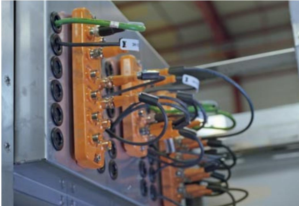
Sämtliche Sensoren und Aktuatoren kommunizieren mittels IO-Link-Modulen mit der Steuerung.
