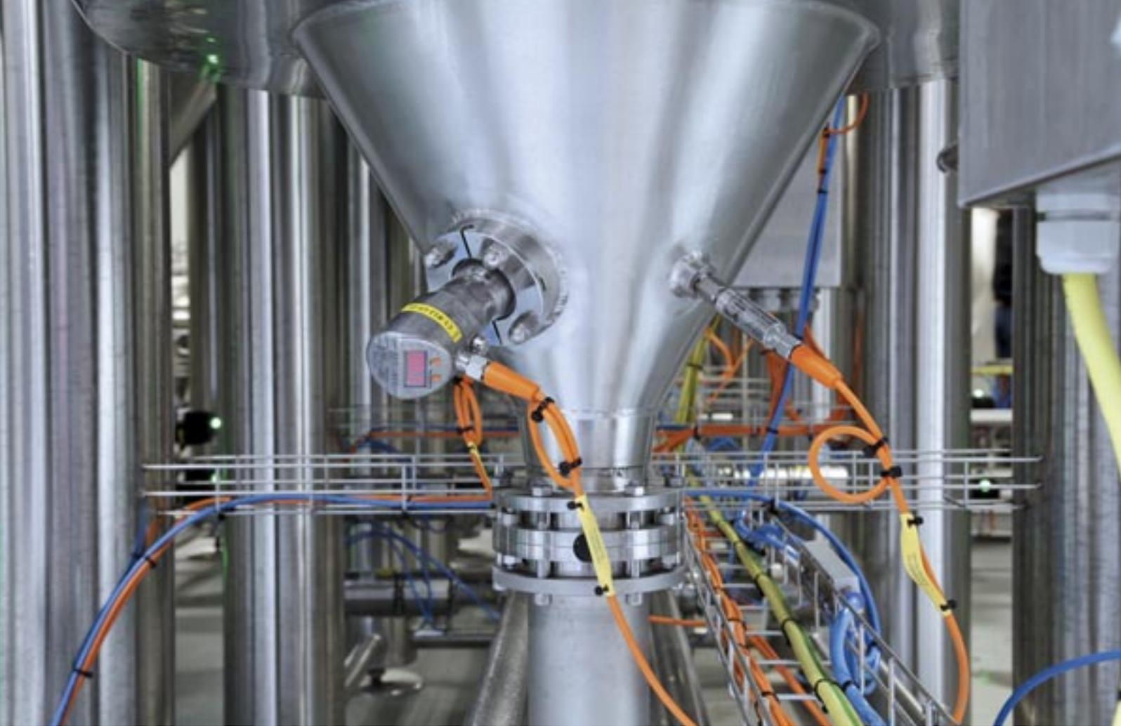
*Für Sicherheit im Brauprozess dienen Drucksensoren zur hydrostatischen Füllstandfassung (links) und Temperatursensoren (rechts).*
