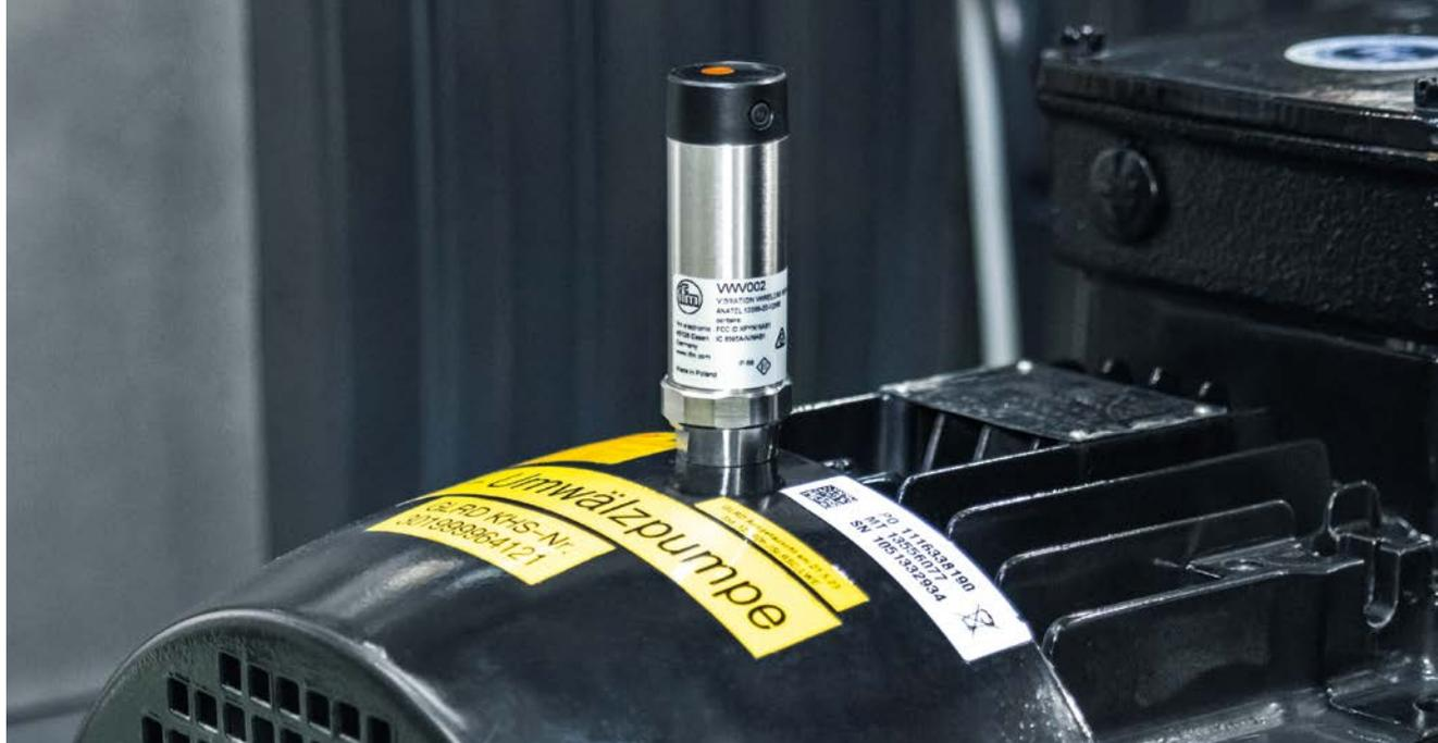
Um sensor de vibração sem fio na bomba de recirculação monitora, de forma confiável e intermitente, a vibração total de acordo com a norma DIN ISO 10816.
