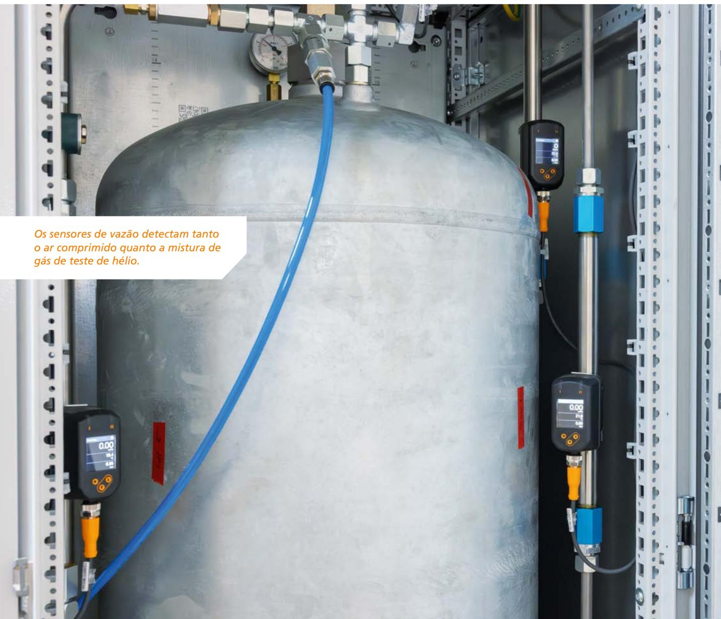
Os sensores de vazão detectam tanto o ar comprimido quanto a mistura de gás de teste de hélio.
