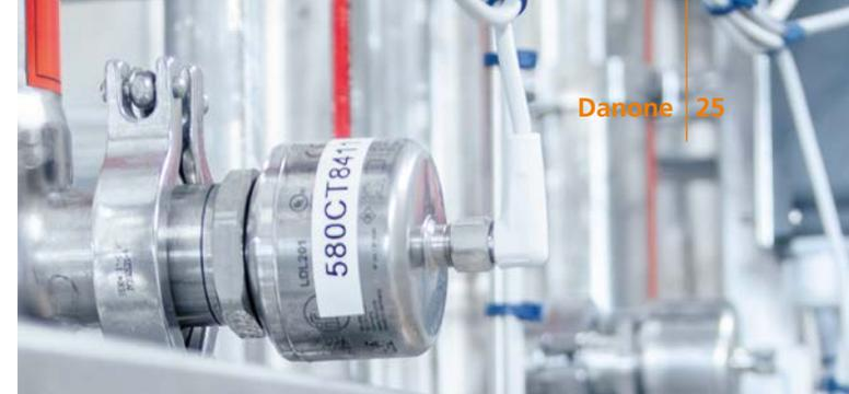
*O sensor de condutividade LDL200 assegura que o processo CIP seja executado de forma correta e eficiente.*
