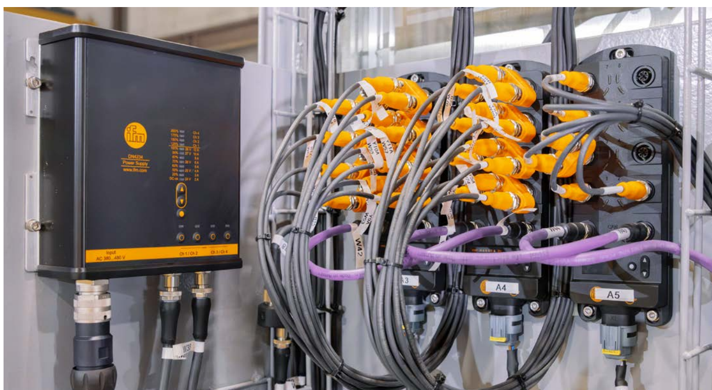
Os módulos I/O realizam a coleta de dados localmente e conectam sensores e atuadores ao controlador da máquina.
