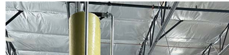
システム全体の中心：メンブレン膜を振動させる20HPのモーターが取り付けられたろ過装置。
