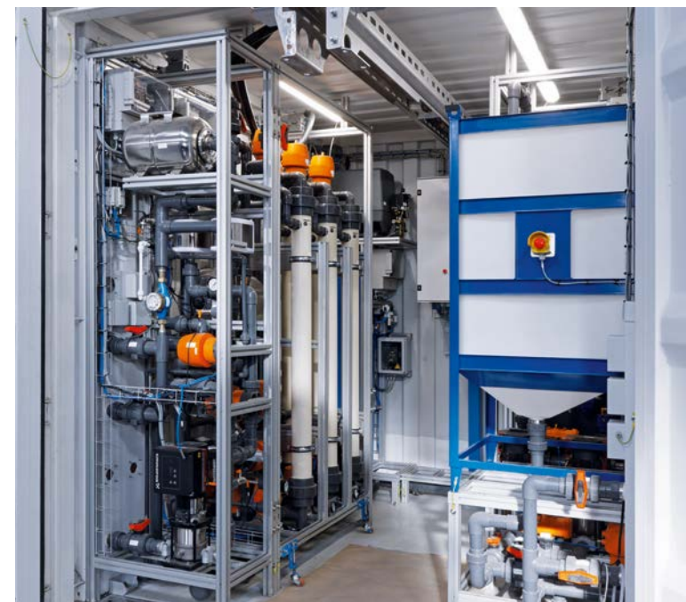
完整的水處理系統整合到緊湊的貨櫃中。
