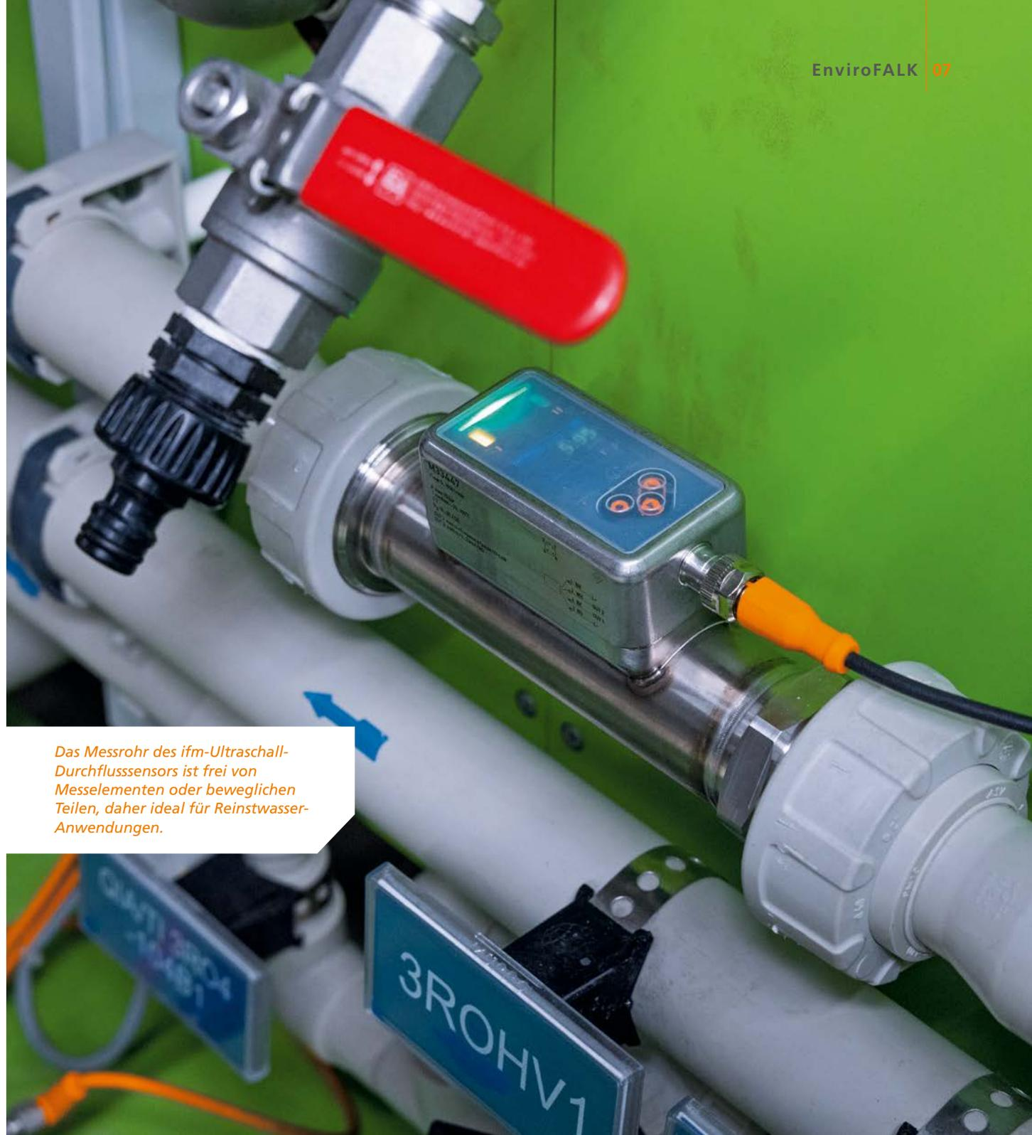
*Das Messrohr des ifm-Ultraschall-Durchflusssensors ist frei von Messelementen oder beweglichen Teilen, daher ideal für Reinstwasser-Anwendungen.*
