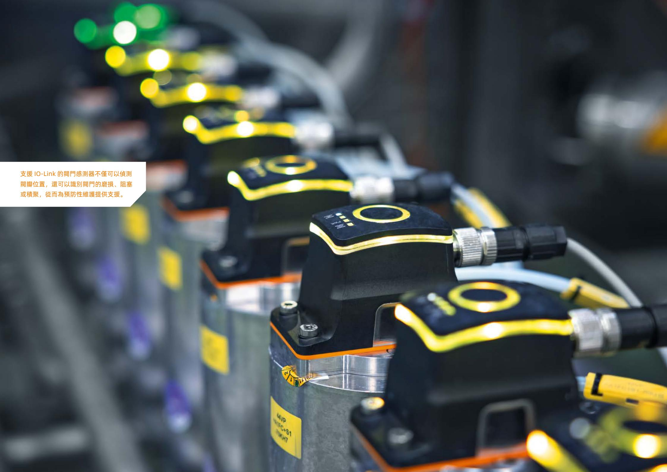
支援 IO-Link 的閥門感測器不僅可以偵測閥瓣位置，還可以識別閥門的磨損、阻塞或積聚，從而為預防性維護提供支援。
