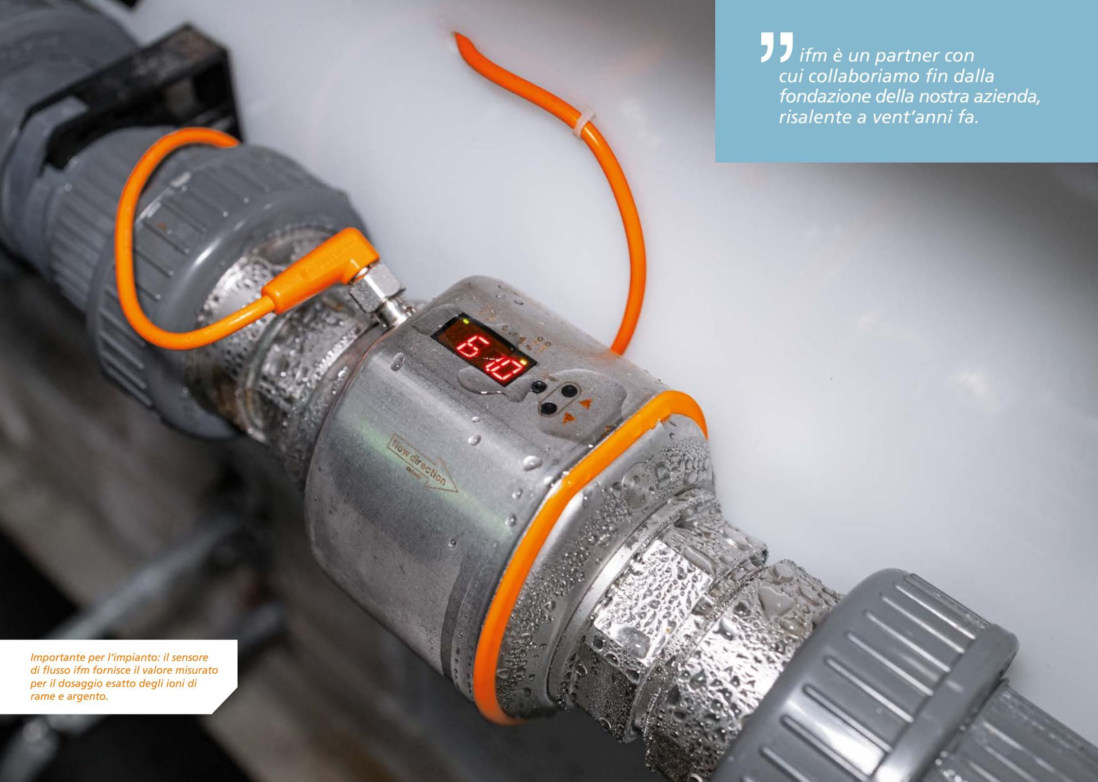
*Massima trasparenza: i parametri di processo sono chiaramente visualizzati sul display dell'impianto.*
