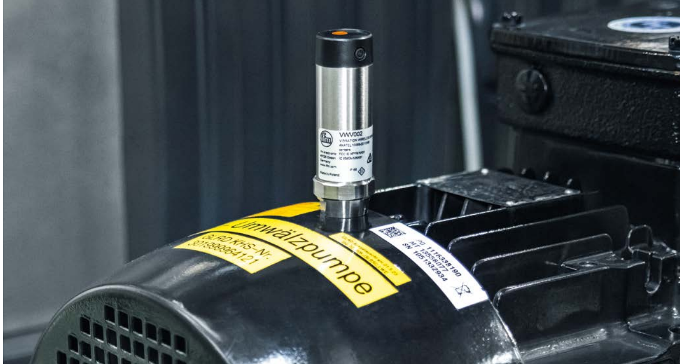
Un sensore di vibrazioni wireless sulla pompa di circolazione per un monitoraggio affidabile e intermittente delle vibrazioni totali secondo la norma DIN ISO 10816.
