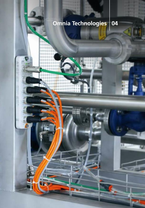
« Grâce à IO-Link, nous économisons donc des points de mesure, des mètres de câbles, et aussi du temps lors de l'installation », affirme Sanson.
