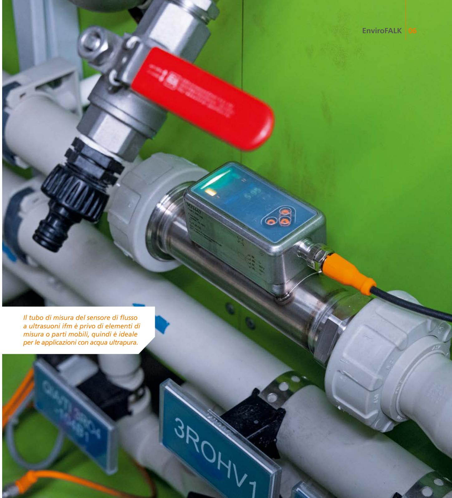
*Il tubo di misura del sensore di flusso a ultrasuoni ifm è privo di elementi di misura o parti mobili, quindi è ideale per le applicazioni con acqua ultrapura.*
