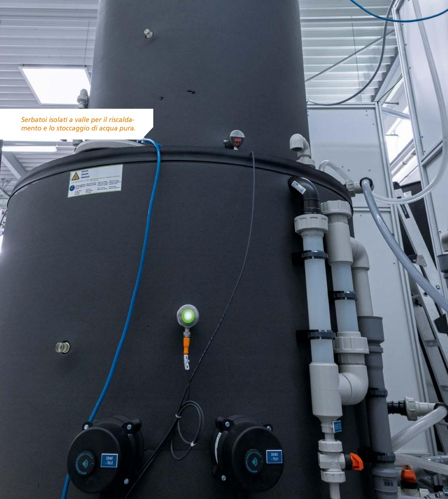
Serbatoi isolati a valle per il riscaldamento e lo stoccaggio di acqua pura.
