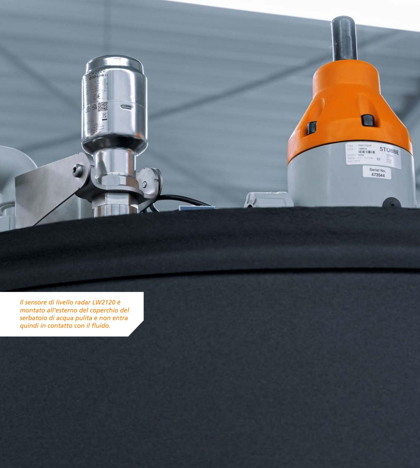
*Il sensore di livello radar LW2120 è montato all'esterno del coperchio del serbatoio di acqua pulita e non entra quindi in contatto con il fluido.*
