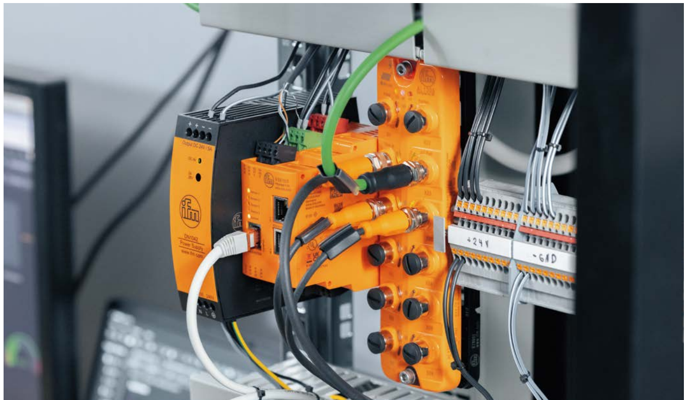
기계의 컨트롤 캐비닛에 파워서플라이, 진동 진단 평가장치 및 IO-Link 마스터가 있습니다.
