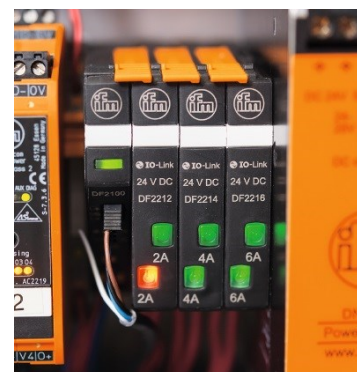
多くの診断情報を提供するIO-Link対応電子サーキットプロテクタ
