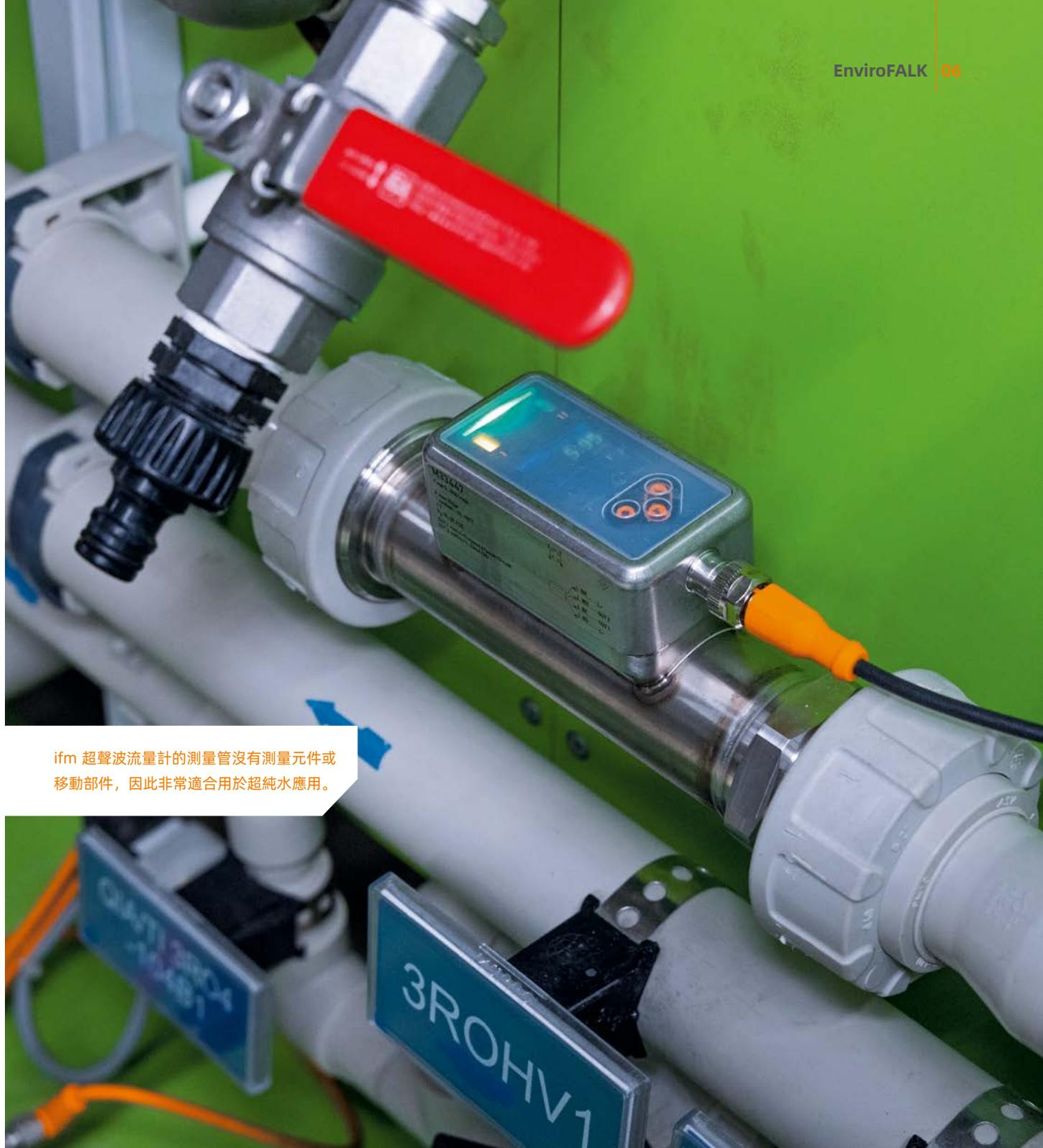
ifm 超聲波流量計的測量管沒有測量元件或移動部件，因此非常適合用於超純水應用。
