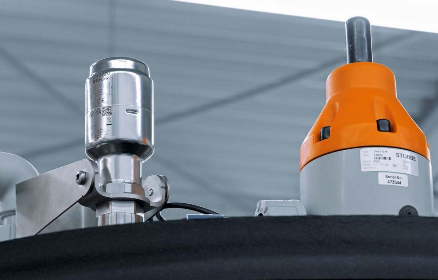
無接觸 LW2120 雷達液位感應器安裝在純水儲罐罐蓋外。
