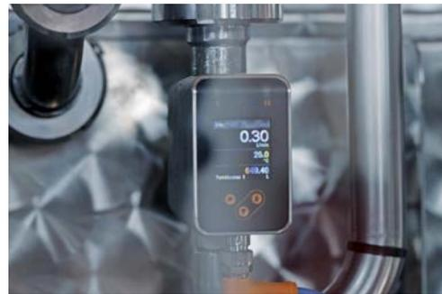
wasser wird am Auslass durch die Wasserdosier Vorrichtung behandelt. Zuvor wurden Vortex-Strömungswächter verschiedener Hersteller verwendet, um die Steuerung und Datenerfassung des Wasserdosiersystems umsetzen zu können. Diese Sensoren erforderten eine starre Einbauvorgabe mit gerader Ein- und Auslaufstrecke, um keine Verwirbelungen zu erzeugen. Dies ließ sich nicht immer realisieren. Außerdem war die Inbetriebnahme oft umständlich.
