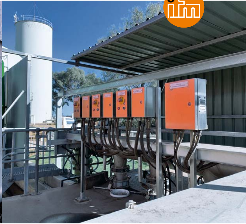
IO-Link를 통해 MVQ의 설치 및 교체가 매우 쉬워졌습니다. 또한 MVQ는 호주 기후의 직접적인 영향에도 내구성을 지닙니다.
