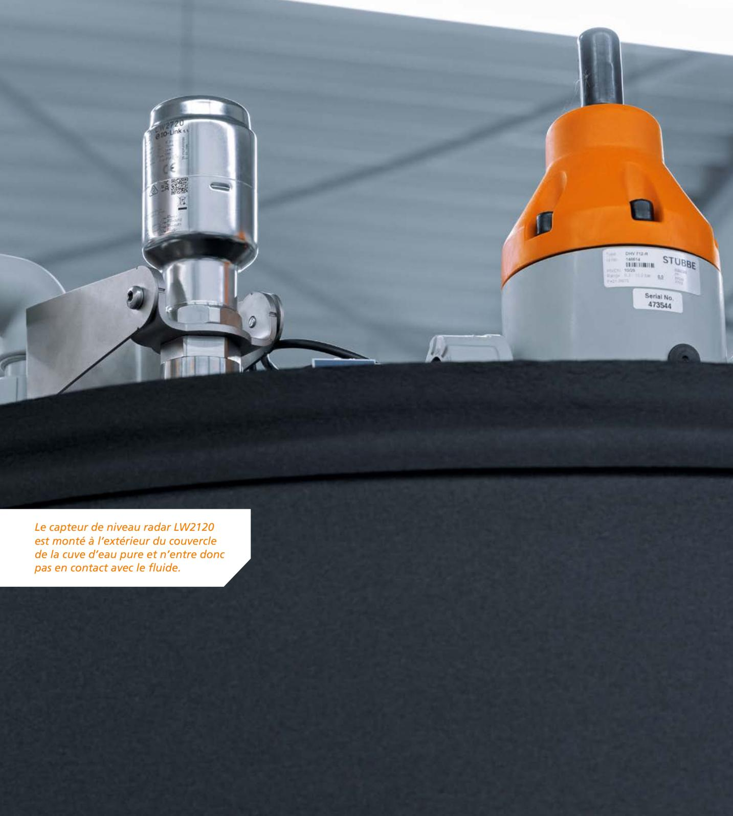
**Le capteur de niveau radar LW2120 est monté à l'extérieur du couvercle de la cuve d'eau pure et n'entre donc pas en contact avec le fluide.**
