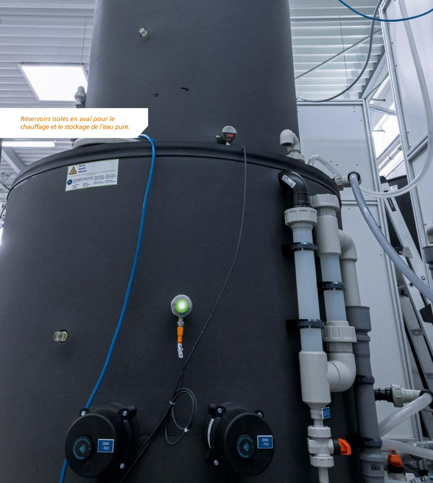
Réservoirs isolés en aval pour le chauffage et le stockage de l'eau pure.
