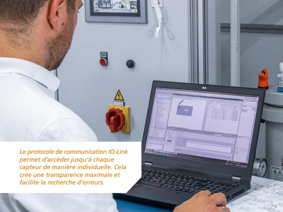
*Le protocole de communication IO-Link permet d'accéder jusqu'à chaque capteur de manière individuelle. Cela crée une transparence maximale et facilite la recherche d'erreurs.*
