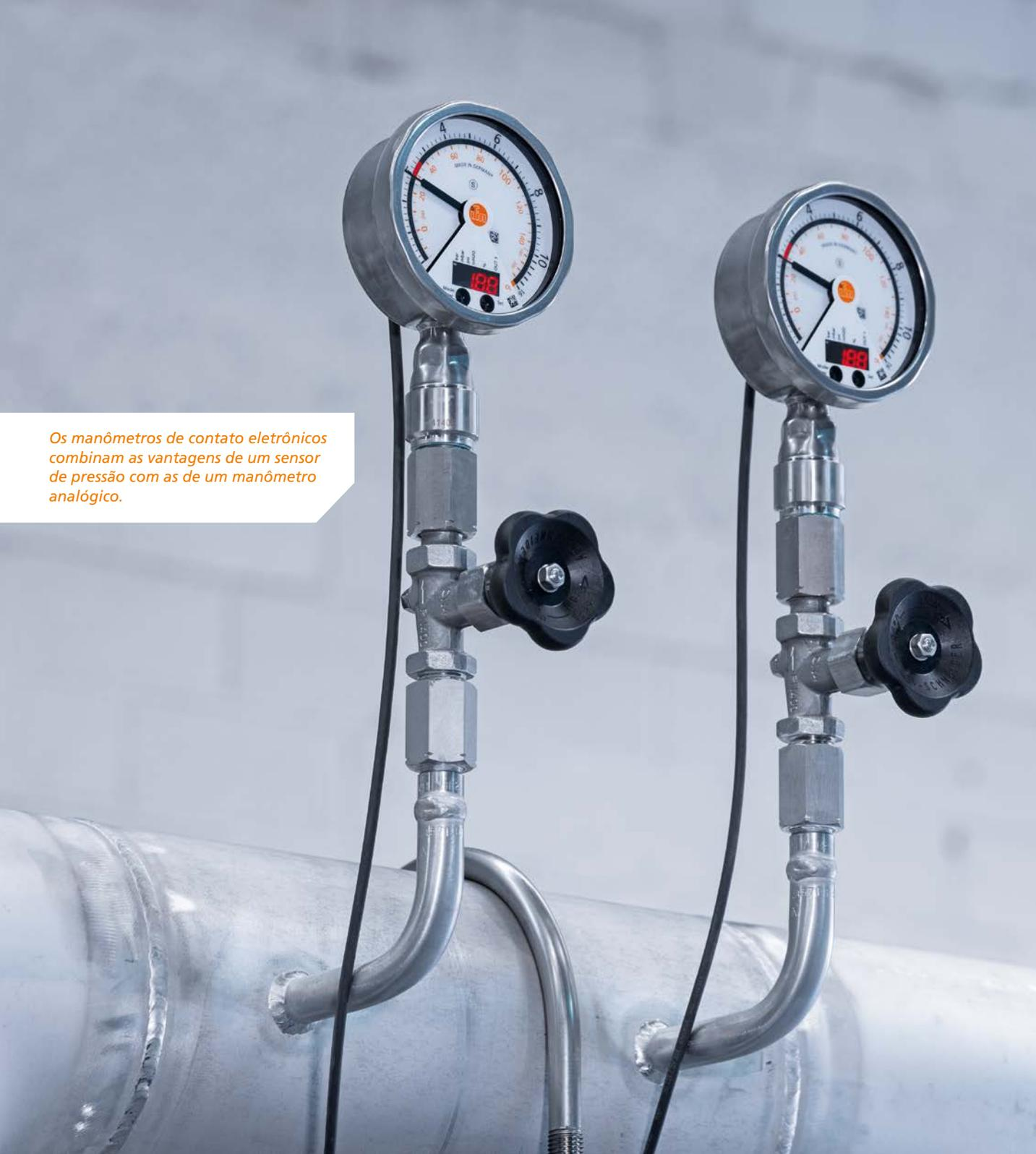
Os manômetros de contato eletrônico combinam as vantagens de um sensor de pressão com as de um manômetro analógico.
