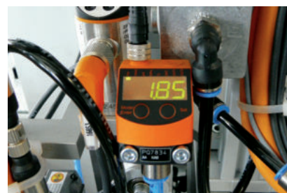
空圧システム の圧力測定
