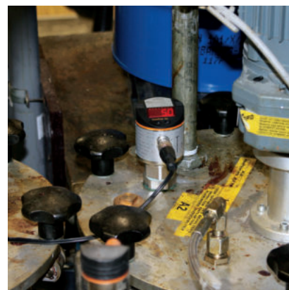
特殊アプリケーション用 タンク上部に 取り付けられた 静電容量式レベルセンサー
